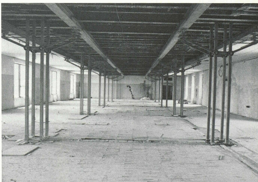
Fig. 1. — Vue intérieure du bâtiment, d'une largeur de 16 m, avant la mise en place du cloisonnement.
