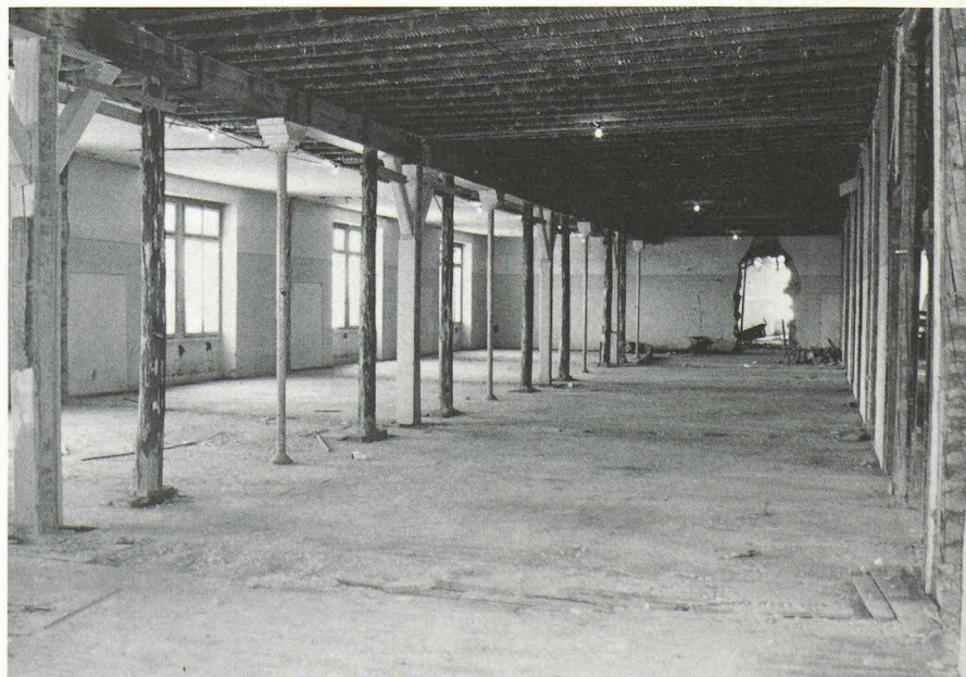
Fig. 1. — La structure existante.
