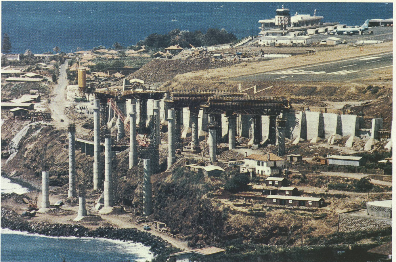
Fig. 13. — Extension de la piste à l'extrémité 24 : vue générale du chantier. On distingue (de gauche à droite) les piles fondées en mer, le tracé futur de la route d'accès à l'aérogare, la réalisation des sommiers à l'aide de poutres en treillis, le mur de soutènement et l'aérogare avec l'aire de stationnement. Cette vue met également en évidence les contraintes imposées par le maintien du trafic aérien.
