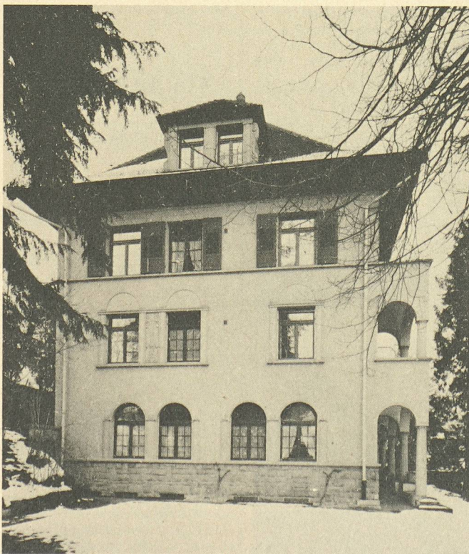
La maison de retraite et dispensaire « Béthanie », à Lucerne.
