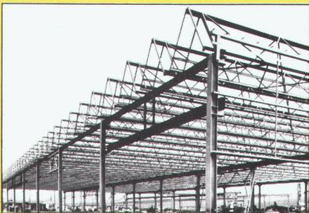
Structure métallique d'une usine – toiture mini-shed –
