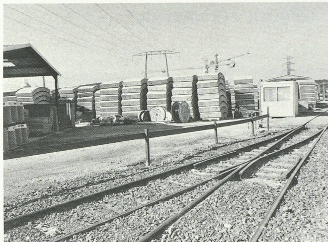
Dépôt de l'usine de préfabrication des voussoirs, à la tête sud du tunnel de Villejust. Le fait que ces éléments ne sont pas identiques exige une identification et une gestion précise de leur manutention.
