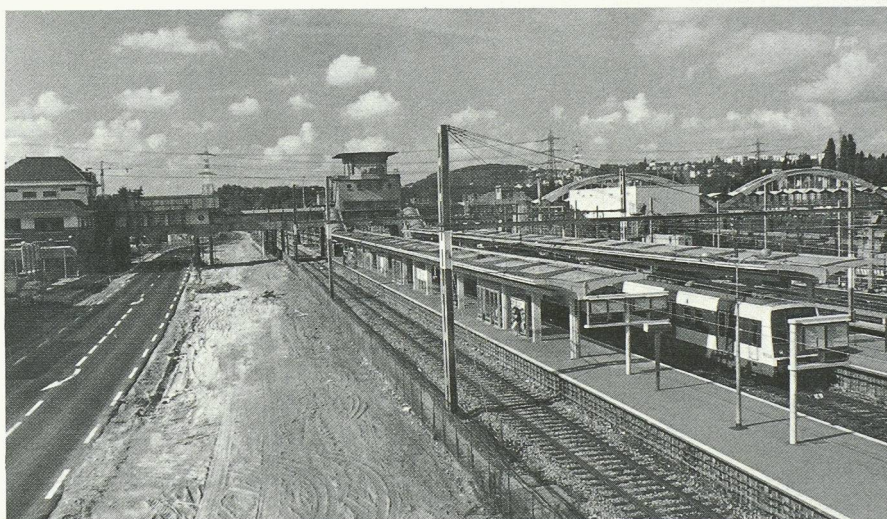
La nouvelle ligne passe sous la gare de Massy-Palaiseau, nœud d'interconnexion encore appelé à se développer.
