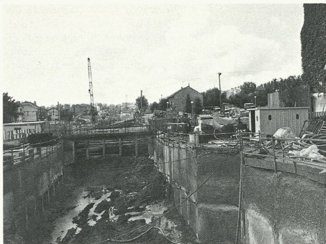
Travaux en milieu urbain : construction à ciel ouvert d'une tranchée couverte à Fontenay-aux-Roses.
