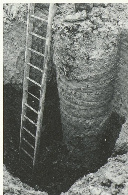
Fig. 11. - N1, Ependes, vue du pieu bétonné et durci; le géotextile a été enlevé.
