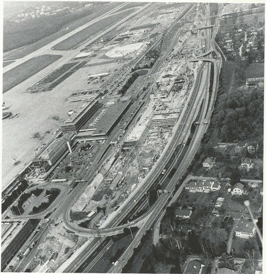
Fig. 11 - Vue générale des grands chantiers situés devant l'aéroport de Genève. (Photo Mediachrom SA, Genève.)
