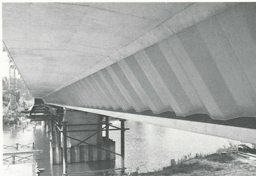
Fig. 9. — Pont de Cognac.
