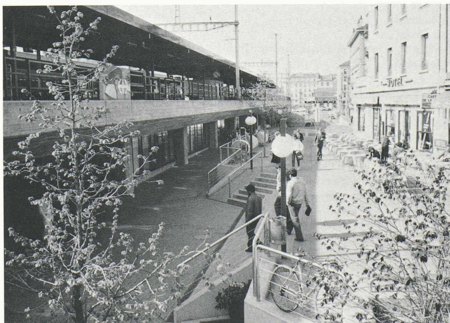
Le nouveau quai 4, vu de la place du Reculet ; les aménagements, réalisés par la Ville de Genève, font de l'ensemble un cadre accueillant. (Photo P.-A. Vaucher/CFF.)
