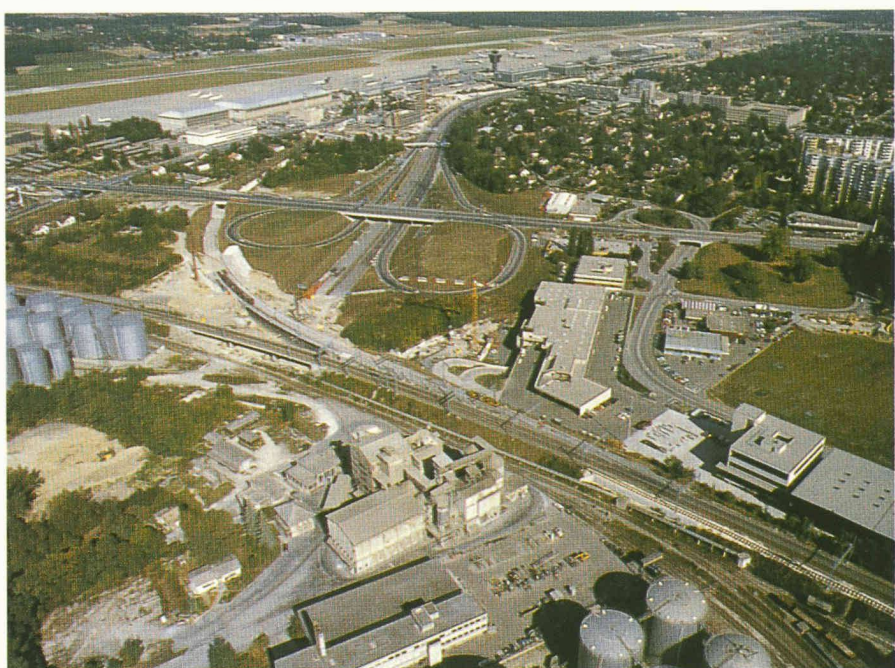
Vue aérienne des travaux en cours. On distingue la bifurcation, les deux ponts franchissant l'autoroute, puis le passage sous la route de Meyrin.
