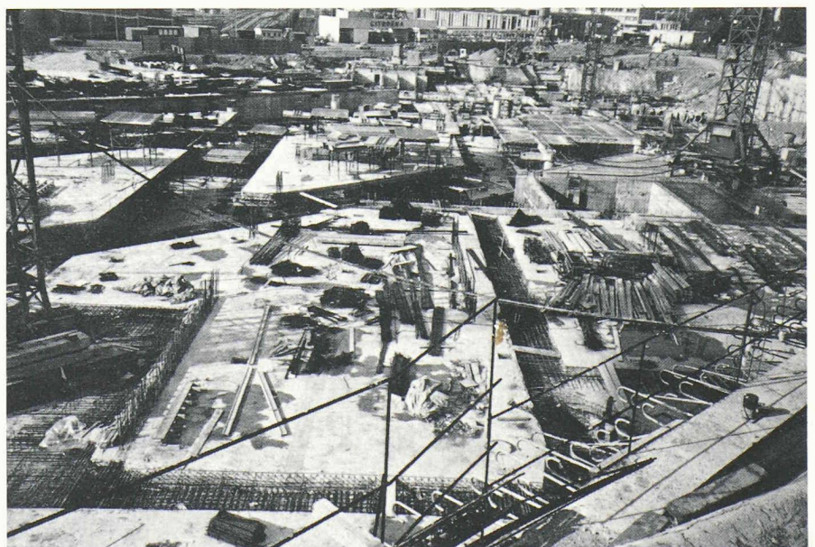
Fig. 9. — Brèches de clavage.
