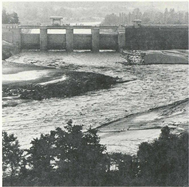
Fig. 7. — Vue d'amont du barrage en chasse (1969) : en rive gauche les restes du dépôt érodé par la déviation des écoulements au moyen du batardeau prolongeant le mur bajoyer centrale-barrage.
