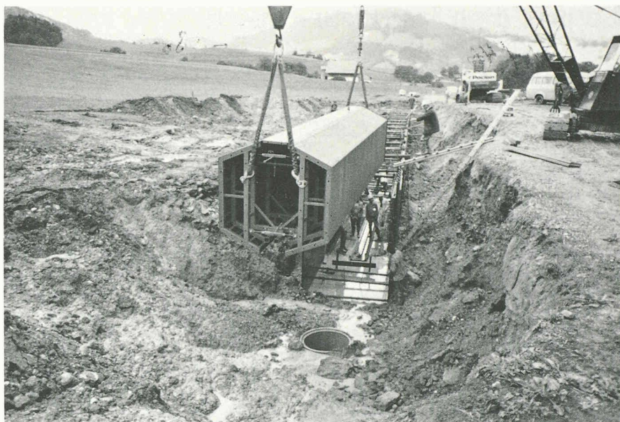
Fig. 4. — Déplacement du coffrage intérieur.
