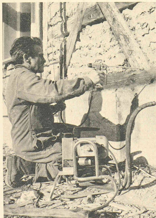
Fig. 2. — Traitement chimique approprié des parties en bois d'un ancien bâtiment.
