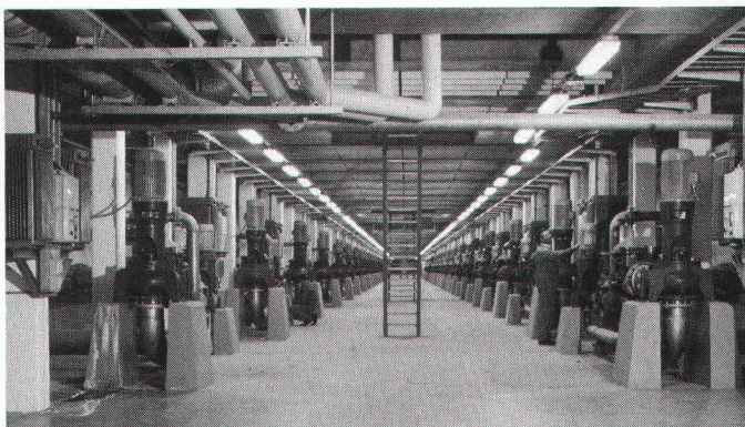
Installation d'épuration Lynetten, Copenhague, 115 pompes TURO.
