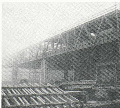
Fig. 6. — Pour maîtresse transversale.
