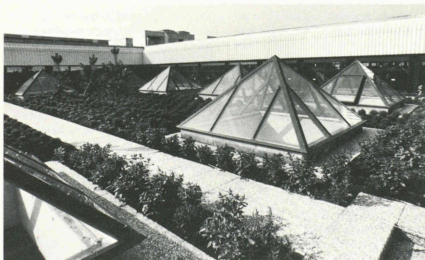
La toiture-jardin est terminée.
