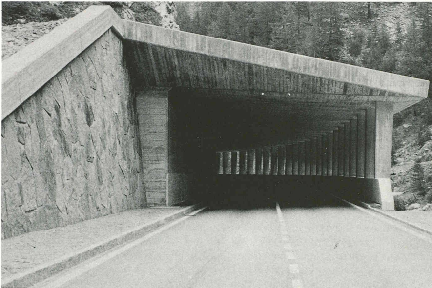
Fig. 10. — Photo du portail ouest de la galerie de Jordighu-Hittini, sur la route du Simplon. (Photo : Bauleitung N9/Simplon, Brigue.)
