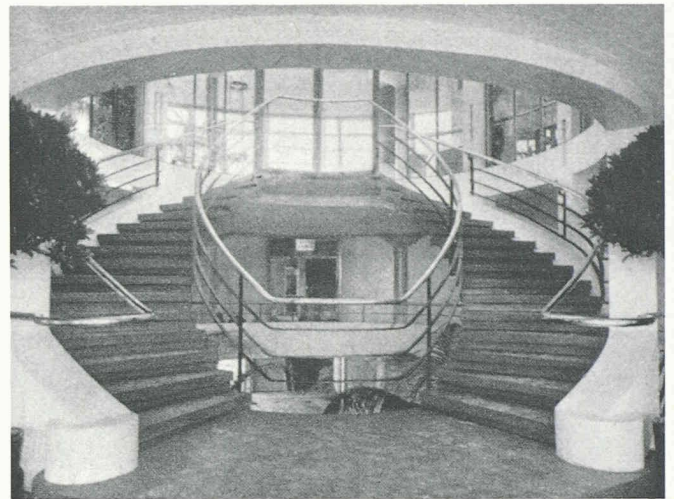
L'escalier central de la rotonde, constitué de marches moulées d'avance et encastrées dans un limon de béton armé.
