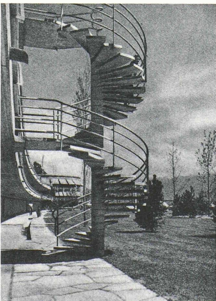
Un des trois escaliers en colimaçon ponctuant la façade de 220 m de long et créant un point d'attraction.
