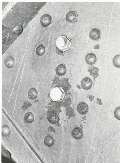
Fig. 12. — Remplacement de rivets par des boulons HR.
