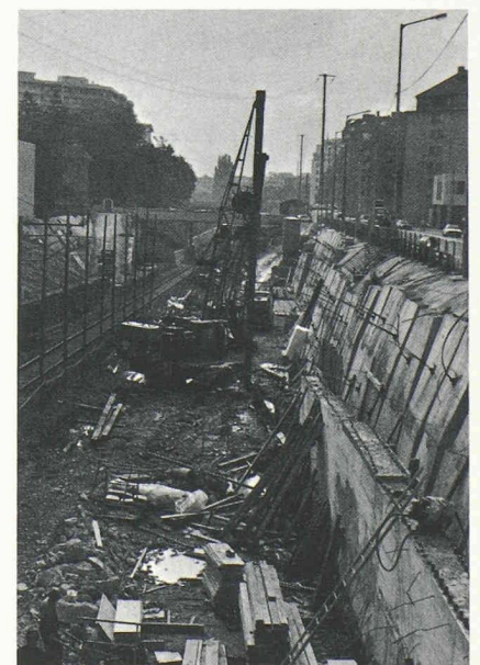
Fig. 12. — Travaux sur le secteur 6 du lot D.
