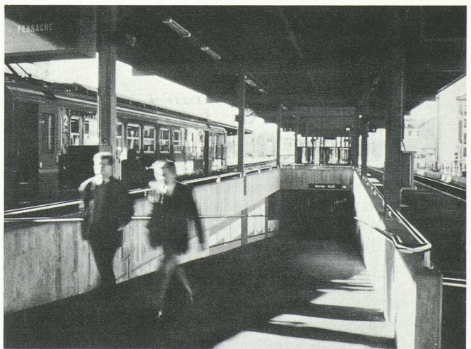
Fig. 10. - Le quai 4: on distingue bien la structure des nouvelles marquises.
