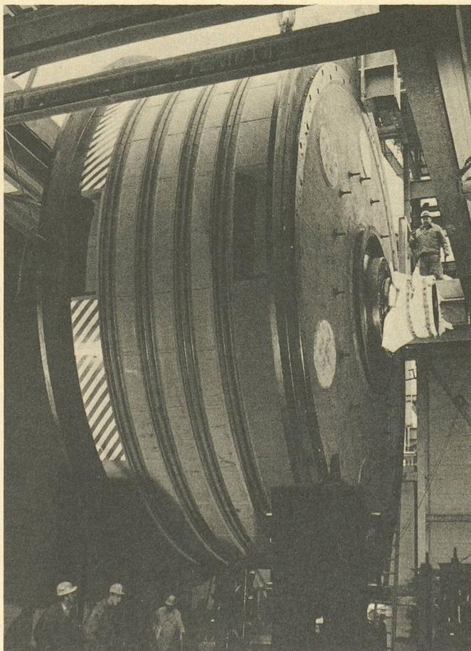
Cette poulie Koepe d'un diamètre de 7,2 m recèle dans son intérieur son moteur d'entraînement, d'une puissance de 2200 kW.
