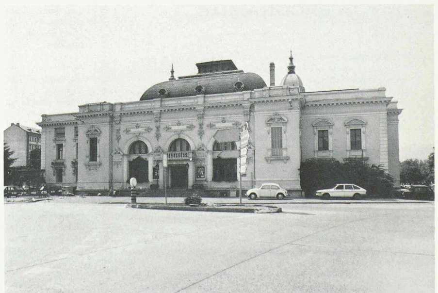
Vue de la façade d'entrée du bâtiment, au levant.
