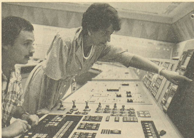
Dans la salle de commande de la centrale nucléaire de Leibstadt: M me Eugénie Zubkovsky indique à l'opérateur les barres de commande qui doivent être déplacées pour atteindre une répartition optimale de la puissance dans le réacteur.
