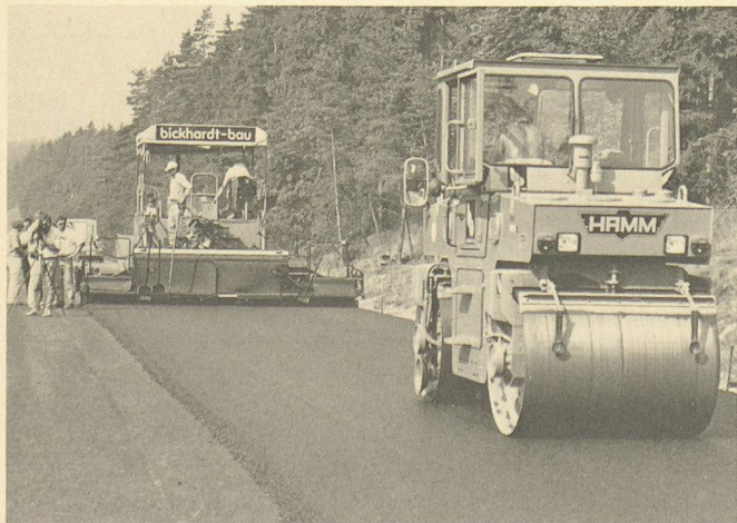
Application du mélange d'asphalte sur le tronçon d'essai de l'autoroute A5. (Photo: Degussa AG.)
