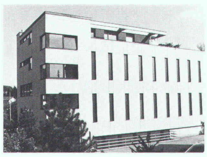
Bâtiment des télécommunications à Unterengstringen
