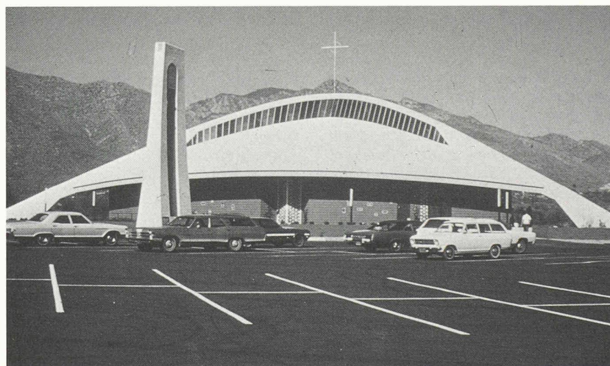
Fig. 7. – Eglise Sainte-Odilla, Tucson, Arizona.
