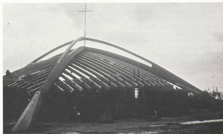
Fig. 8. – Ossature en bois lamellé collé de l'église Sainte-Odilla.
