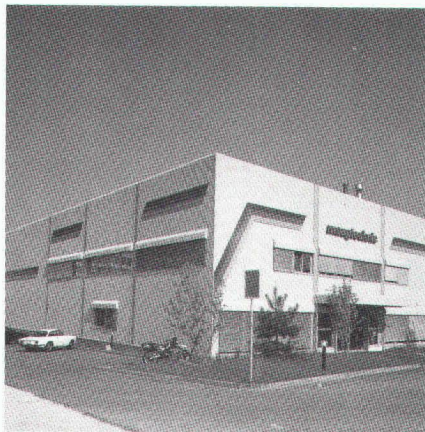
Siège romand de Maag Technic SA, Crissier
