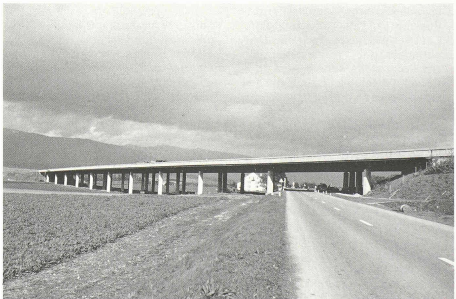
Fig. 2. - Vue des viaducs du Chêne à Chavornay.
