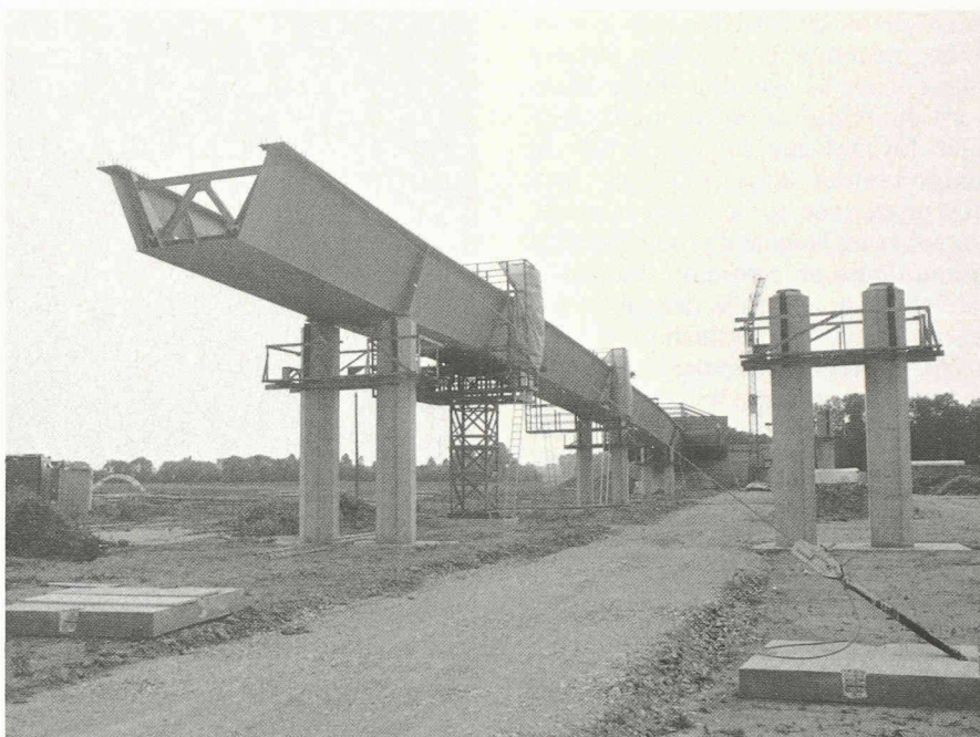
Fig. 4. - Viaduc du Bois-de-Rosset en construction.
