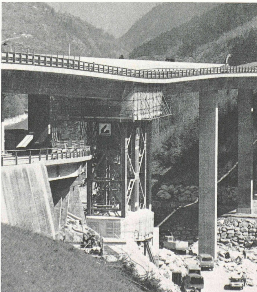
Fig. 1. – Pont de Wassen après affouillement de la fondation d'une pile.
