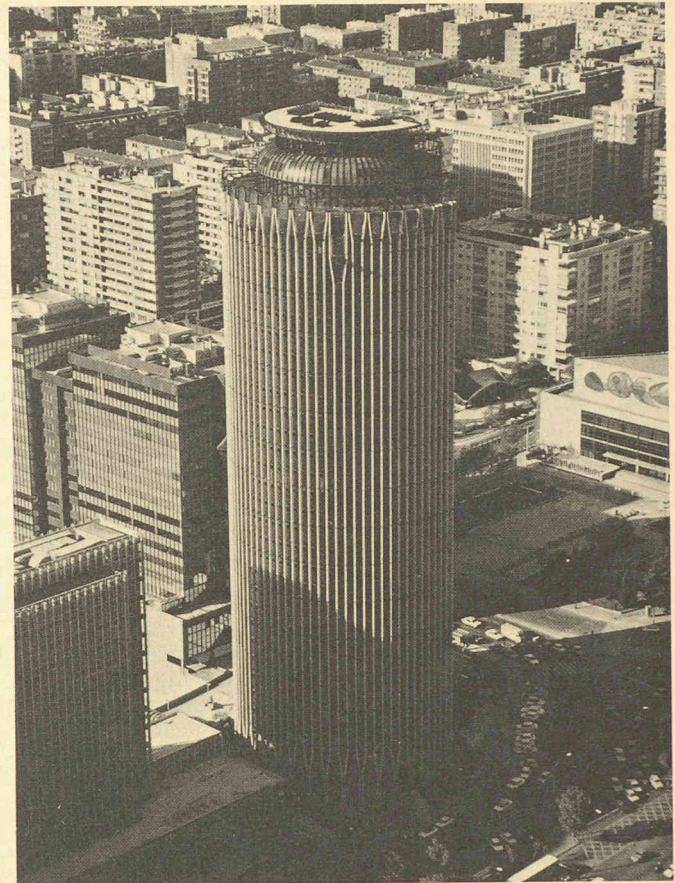
«Torre Europa» à Madrid : installations de climatisation, avec récupération de chaleur, pour un bâtiment administratif de 30 étages. (Photo : Sulzer, Winterthur.)
