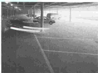
Niveau de parking du centre commercial Glatt, Wallisellen
