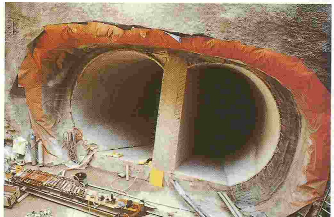
Tunnel est. Même endroit, deux ans plus tard: tête du puits légèrement élargie avec paroi de séparation. Fin des travaux de bétonnage (21 juillet 1989).
