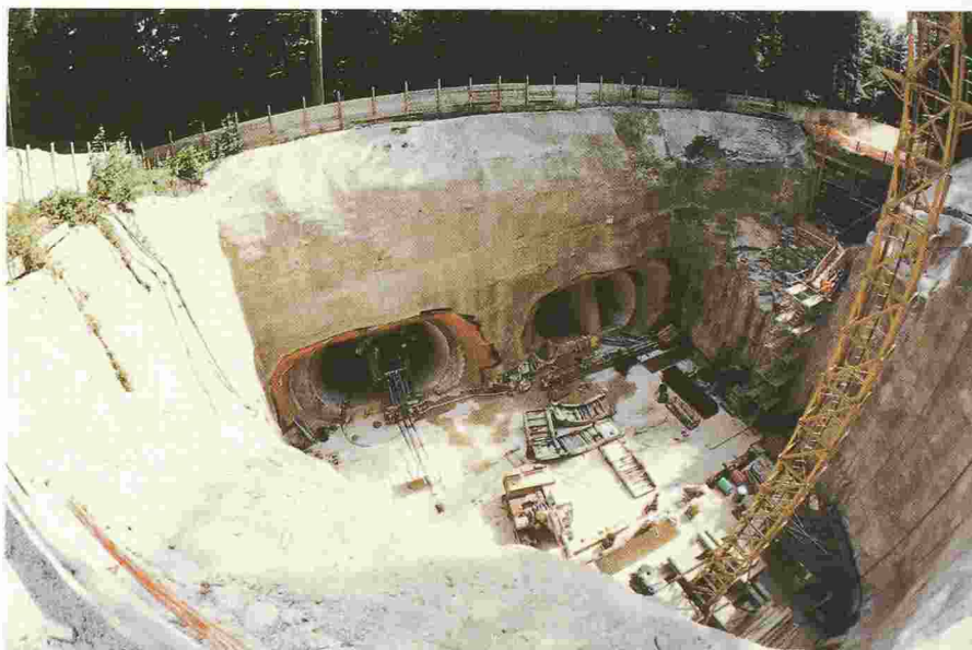
Tunnel est. Fouille de la future centrale de ventilation des Perrolets et les puits de ventilation qui y débouchent. Entièrement souterraine, cette installation forme une sorte de gigantesque aspirateur de 20 m de haut, 31 m de long, 15 m de large en moyenne et qui représente 3000 m 3 de béton et 30 t d'acier d'armature. Ce volume enterré imposant est nécessaire pour abriter les 4 puissants ventilateurs de 5 m de diamètre, pesant 27 t chacun, développant une puissance variant selon les besoins entre 380 et 940 kW et capables d'assurer un débit de 180 à 280 m 3 /s.
