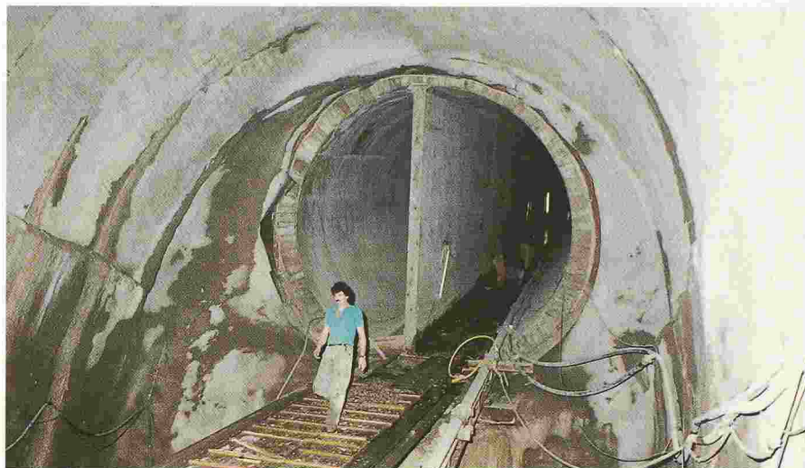
Tunnel est. Pied d'un des deux puits de ventilation en cours de finition après les travaux de revêtement.
