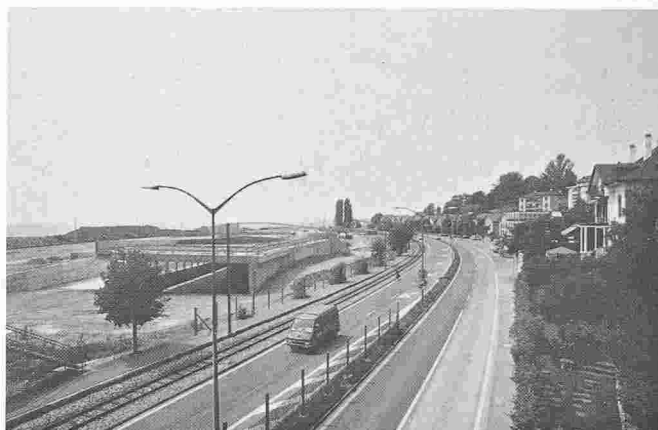
Tunnel ouest. Jonction de Serrières – la partie centrale de la trémie de l'autoroute est construite. On est en train de réaliser la nouvelle voie du Littorail et la future RC5. Dans le courant de cette année, la circulation automobile dans le sens Yverdon–Neuchâtel sera modifiée, empruntant la nouvelle bretelle de la RC5 et imposant un détour par les nouvelles rives. Quant aux usagers du Littorail, ils circulent sur la nouvelle voie depuis fin janvier et s'arrêtent à la nouvelle station.
