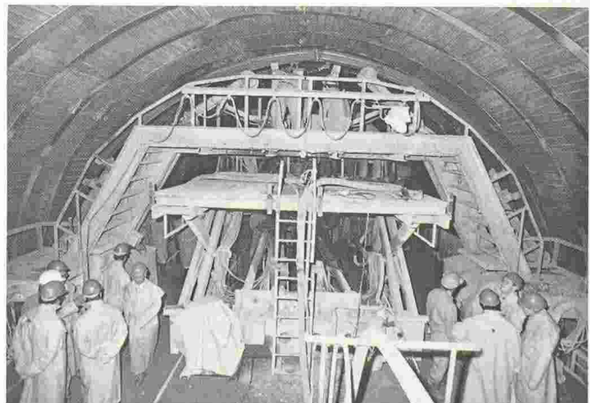
Tunnel est. Plate-forme de travail du traineau de service. Des visiteurs visiblement très intéressés par les travaux d'avancement: les membres SIA du Groupe spécialisé pour les travaux souterrains, lors de leur assemblée du 19 septembre 1985.
