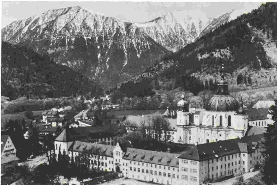
Quel architecte: l'animateur et chef unique du projet, tel qu'on le connaissait jadis? Notre photo: le couvent d'Ettal, dans les Alpes bavaroises, construit par Enrico Zuccali (1642-1724), de Roveredo.
