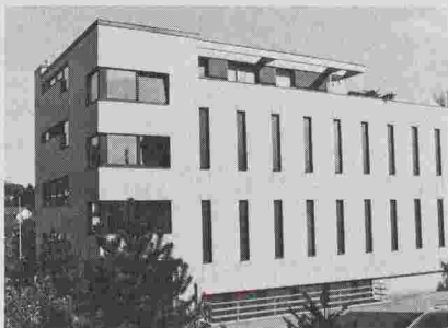
Bâtiment des télécommunications à Unterengstringen
