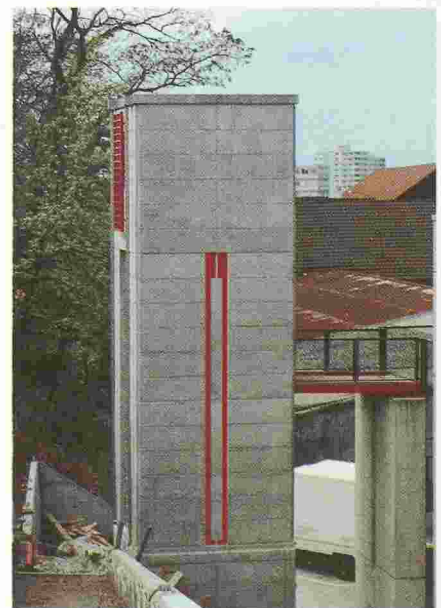
Fig. 4. – Monte-charge construit en remplacement de la passerelle.
