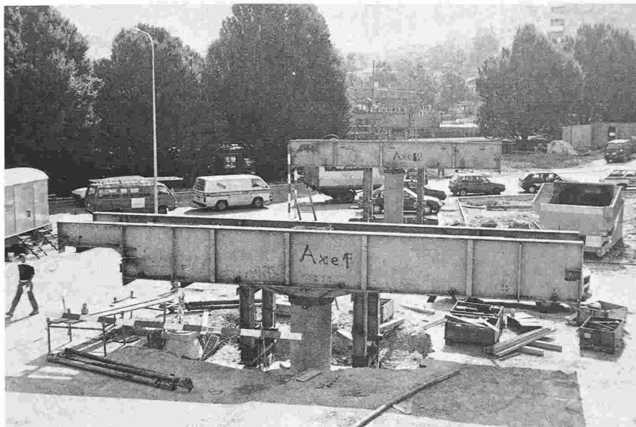
Fig. 2. - Viaduc de Sévelin: coffrages métalliques des piles.
