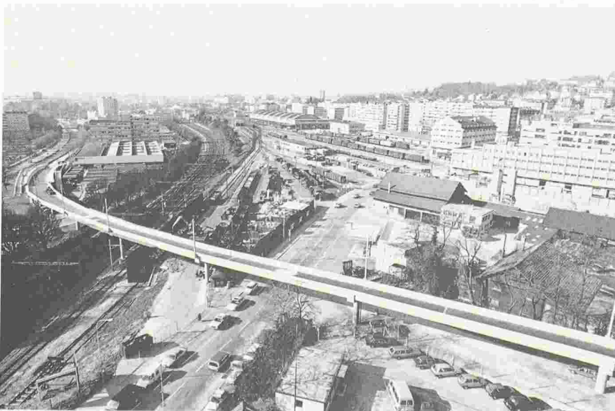
Fig. 1. - Viaduc de Sévelin : vue générale.
