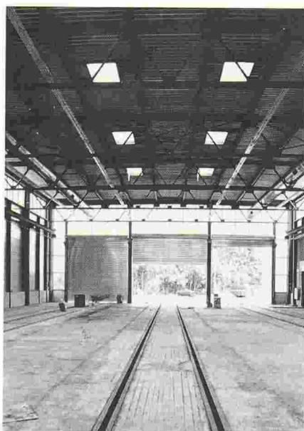
Fig. 5. – Dépôt-atelier: vue de l'intérieur de la halle d'entretien.
