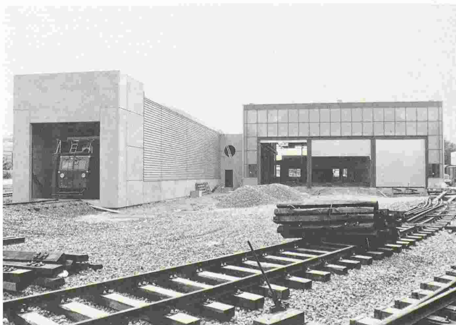
Fig. 4. – Dépôt-atelier: vue depuis l'est.
