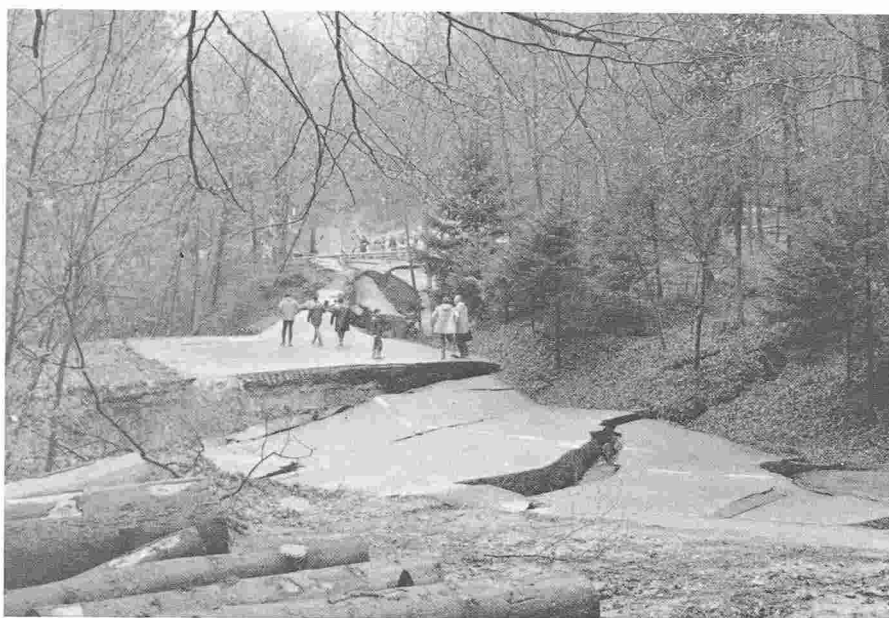
Fig. 1. – La route cantonale 773d, le 21 avril 1983.
