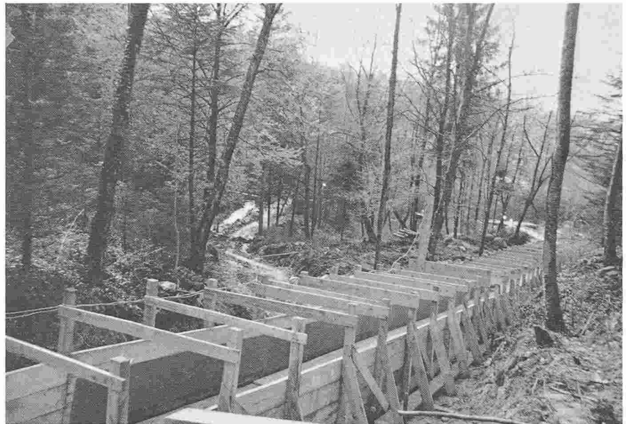
Fig. 3. - Mesure d'urgence, le chenal provisoire.
