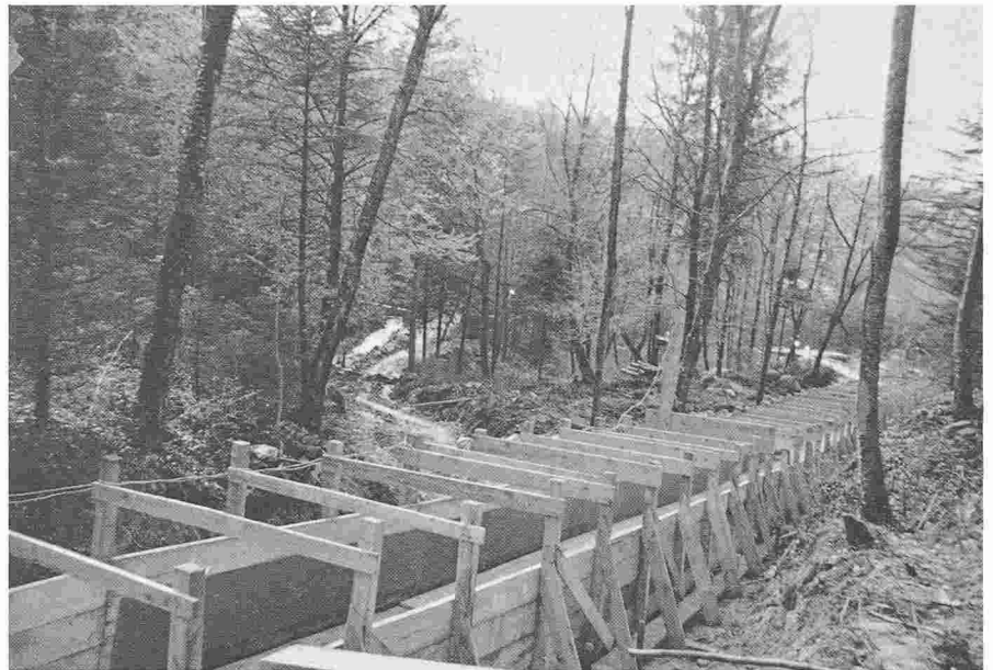
Fig. 3. - Mesure d'urgence, le chenal provisoire.
