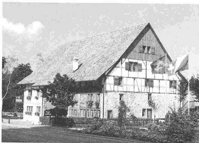
Centre communautaire Stürmeierhuus à Schlieren ZH (Freiestrasse 14); maître d'ouvrage: Evangelisch-reformierte Kirchgemeinde Schlieren; architecte: LAD J. Pujol, Schlieren.
