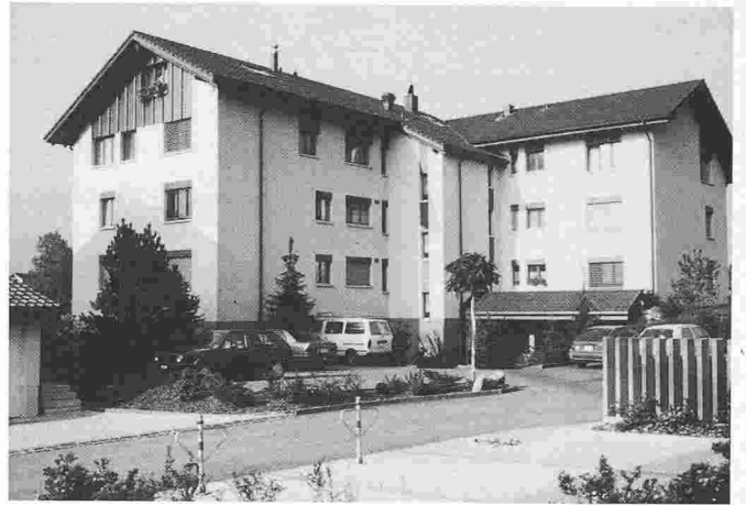
Maison d'habitation Rietwies à Wangen SZ (Sonnenriedstrasse 6); architectes: Eggenberger & Schättin AG, Wangen.
