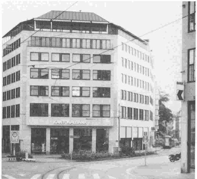
Basler Kantonalbank, siège principal à Bâle (Spielgelgasse 1); maître d'ouvrage: Basler Kantonalbank; architecte: Schwarz + Gutmann, Bâle.
