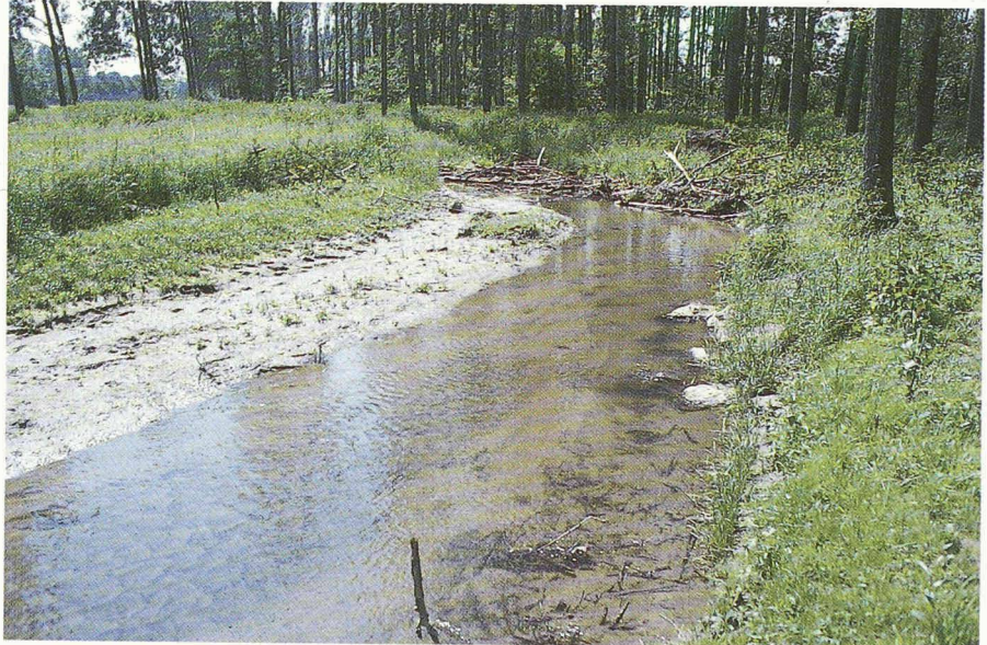
Wieseck. Le nouveau lit est quasiment sans protection ; sur la rive intérieure se forment des alluvions ; l'accumulation de branchages crée des biotopes propres aux cours d'eau.
