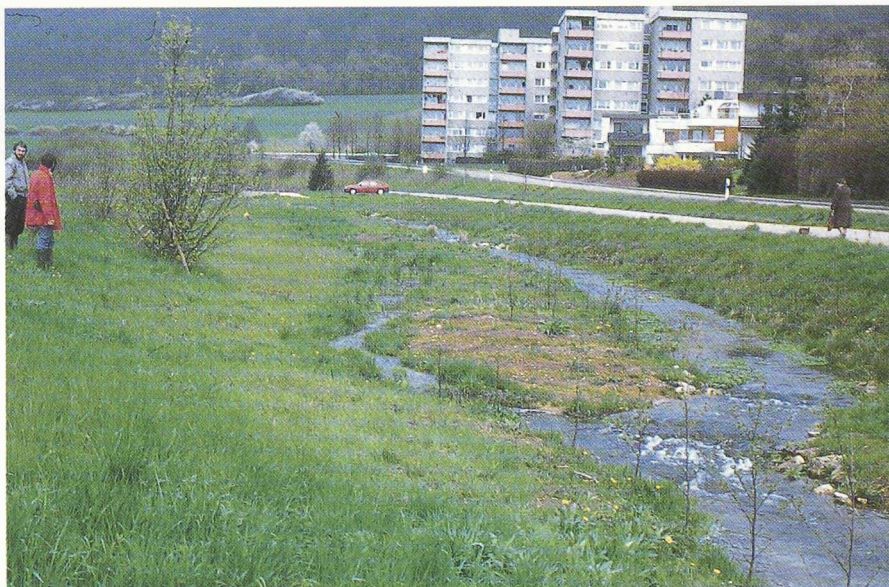
Gutenbach près d'Oberkochen. Après la transformation, un lit proche d'un état naturel s'est formé rapidement.
