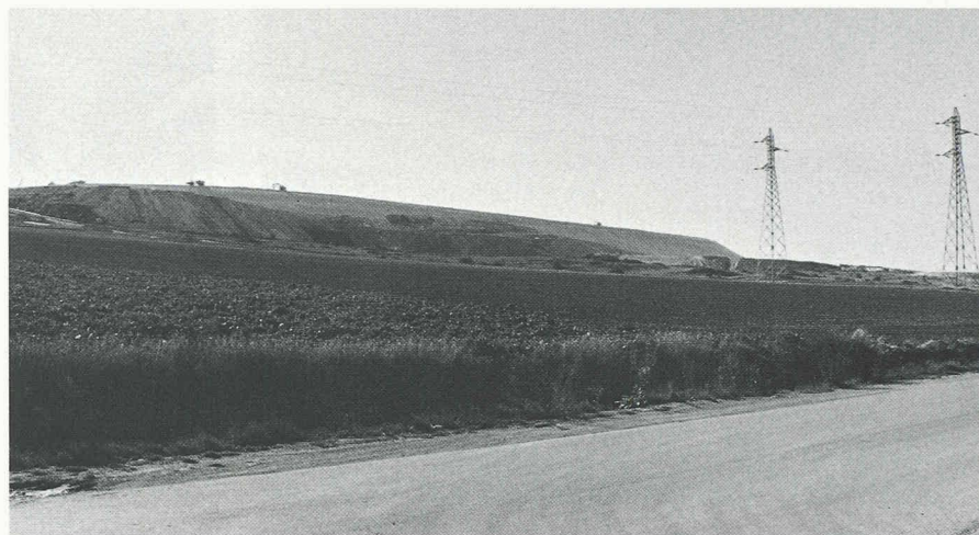
Fig. 13. – Vue depuis l'entrée du chantier de Sangatte en direction du dépôt des déblais à Fond-Pignon.
