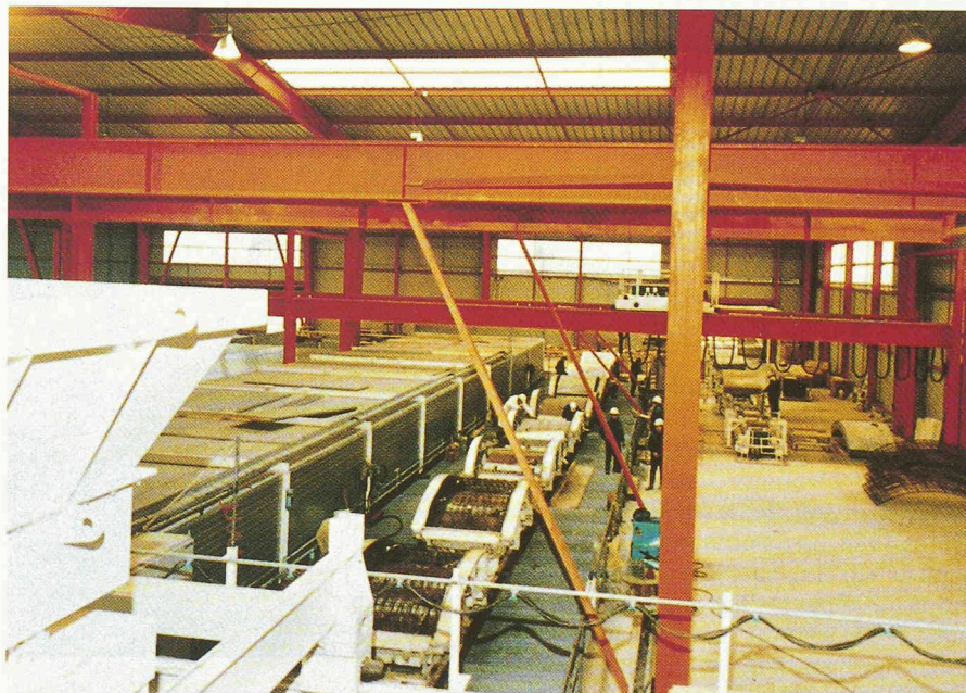
Fig. 17. - Usine de préfabrication des voussoirs. Chaque voussoir est armé d'une cage métallique qui garantit la pérennité de l'ouvrage pour au moins 100 ans.
