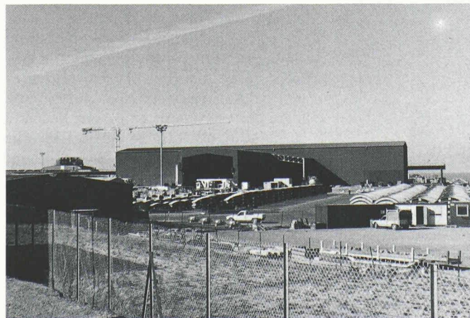
Fig. 2. - Abri en forme de hangar, situé au centre du chantier de Sangatte.
