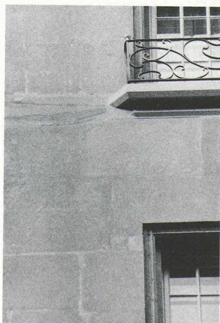
Fig. 12. – Tablette de fenêtre remplacée par une pièce en pierre naturelle et intégrée dans une façade uniquement nettoyée, non restaurée.
