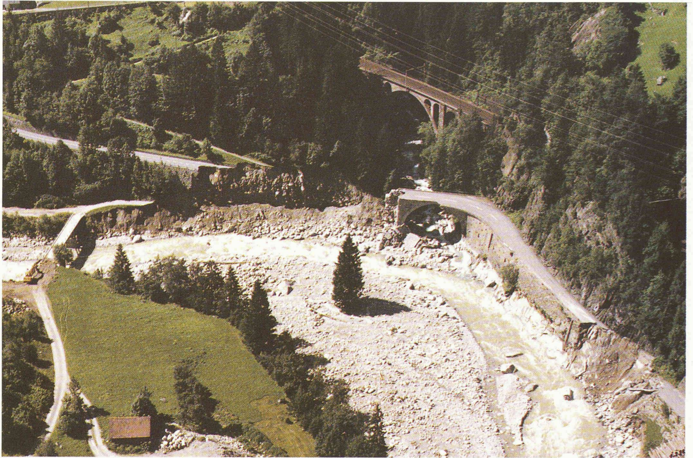
Fig. 1. – La route du Saint-Gothard détruite dans la région du pont sur la Meienreuss à Wassen. (Photo Office des Travaux publics d'Uri.)
