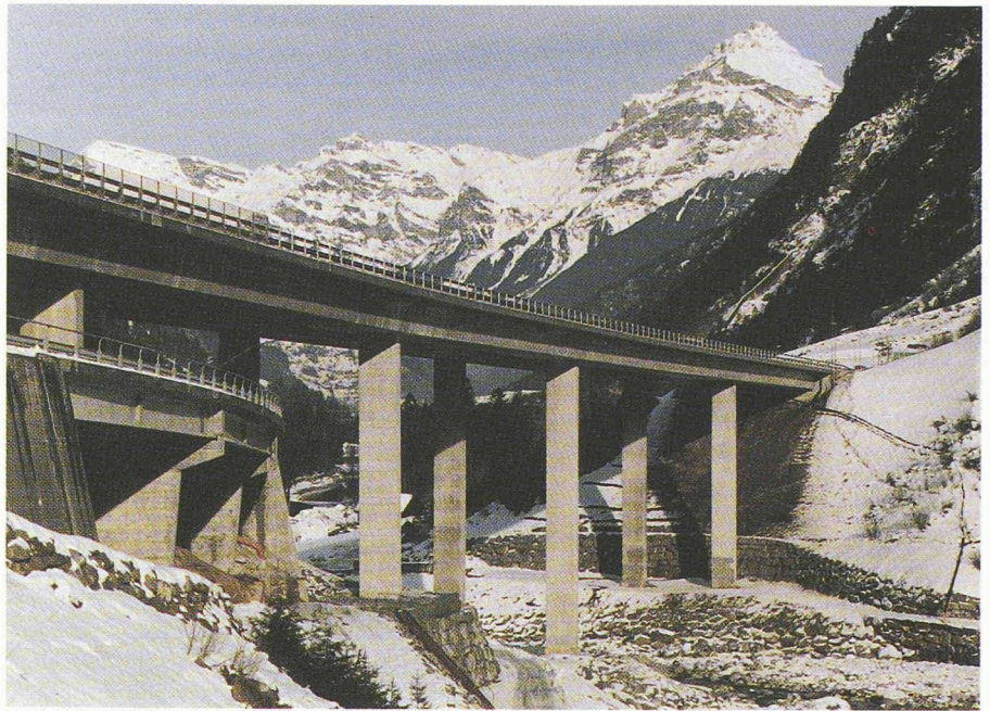
Fig. 8. - Le pont reconstruit.
