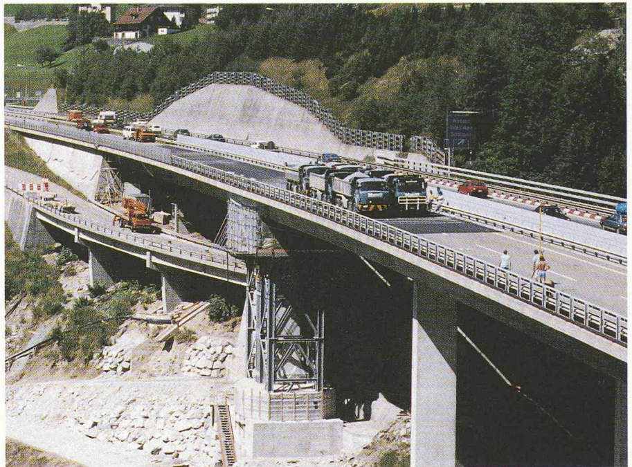
Fig. 14. - Essai de charge avec six camions à quatre essieux, juillet 1988.
