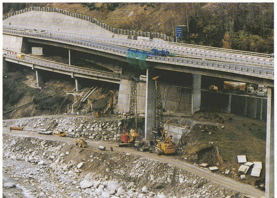
Fig. 6. – Vue d'ensemble des travaux de forage des pieux: deux engins de forage au pied de la pile J. (Photo A. von Glutz.)
