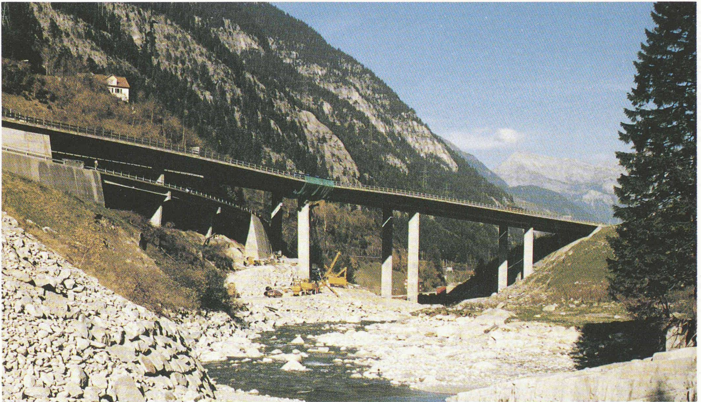
Fig. 2. - Vue générale du pont et du cours de la Reuss en direction du nord, octobre 1987.
