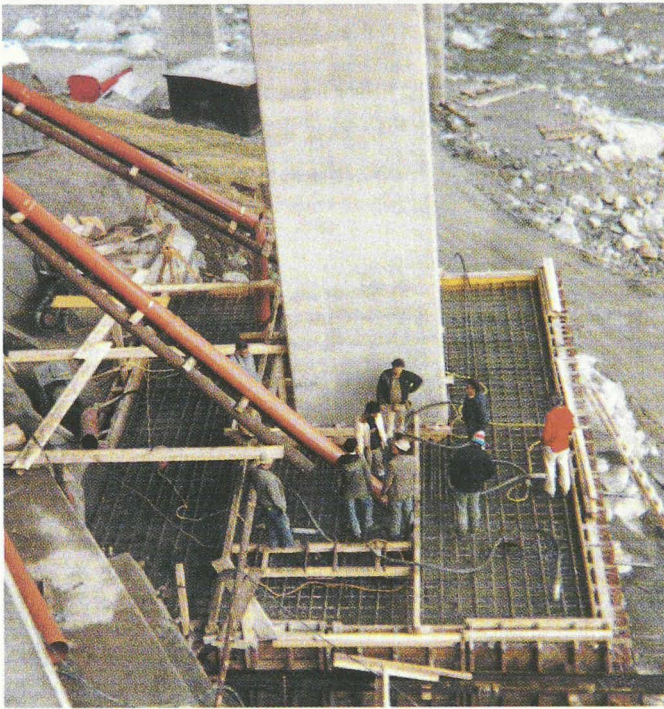
Fig. 6. – Bétonnage de la nouvelle fondation. (Photo R. Kalbermatten.)
