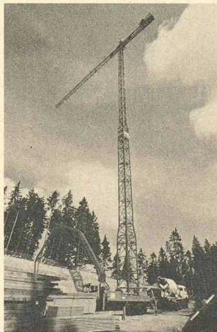
Grue système à flèche horizontale Wolff WK 90 SL2, avec une hauteur sous crochet de 82,5 m, sans haubanage.
